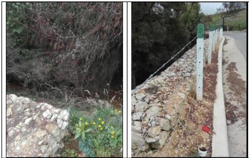
Foto 3 y 4. Muros de contención.
